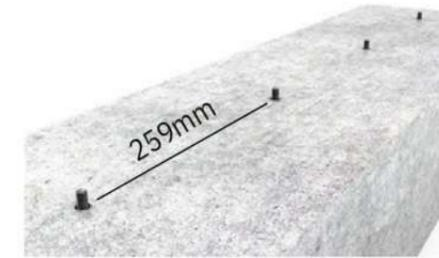
1. Bohren, absaugen, Kleber und chemischen Anker einbringen.
