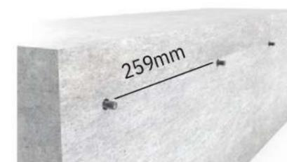
1. Bohren, absaugen, Kleber und Verbundanker einsetzen.
