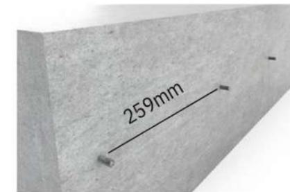
1. Bohren, absaugen, Kleber und Verbundanker einsetzen.
